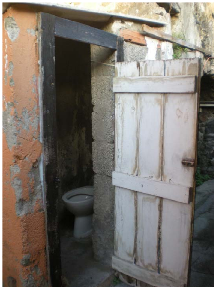
FOTO N° 05 – VANO BAGNO IN PIANO TERRA
