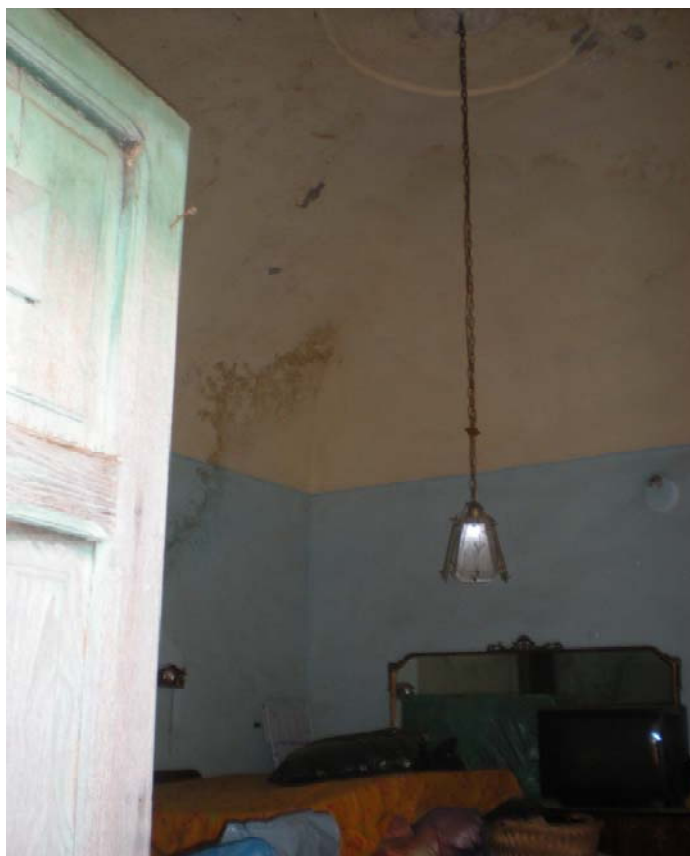
FOTO N° 07 – INGRESSO E CONDIZIONI ATTUALI DEL VANO IN PIANO PRIMO
