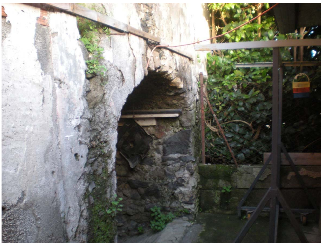
FOTO N° 06 – ACCESSO AL PIANO CANTINATO
