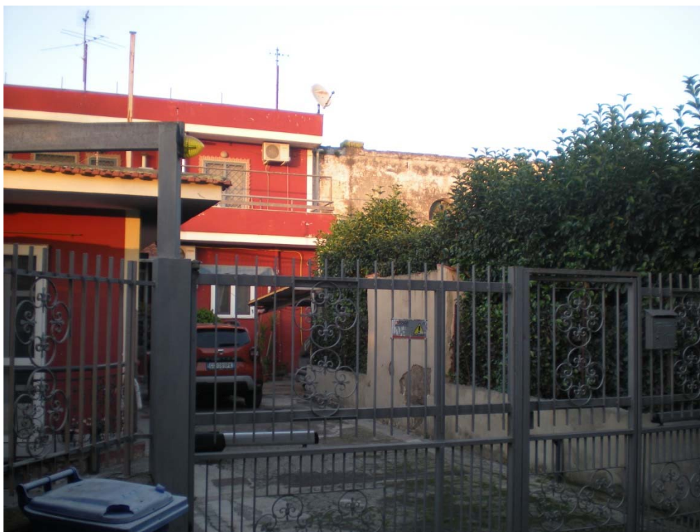
FOTO N° 02 – INGRESSO ALLA PROPRIETA' DEL SIG. [REDACTED] DA T.SA FIORE, ATTRAVERSO L'UNICO INGRESSO IN COMUNE CON [REDACTED]
