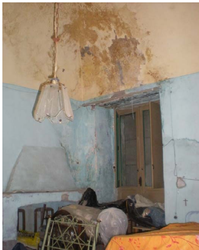
FOTO N° 08 – CONDIZIONI ATTUALI INTERNE DEL VANO IN PIANO PRIMO
